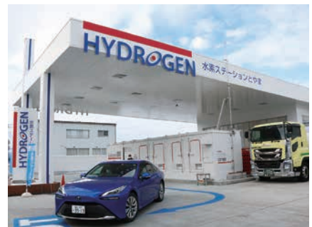
水素ステーション
